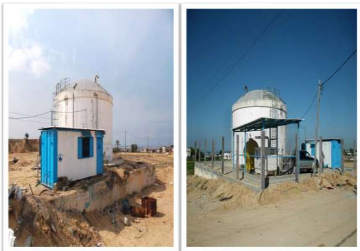
Figure 32: Wadi Al Salqa Water Tank
